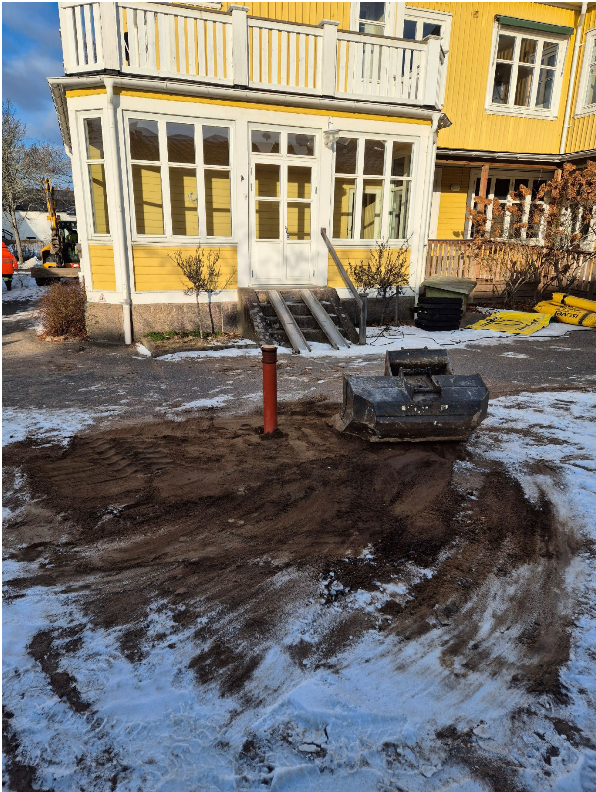
Figur 5: Provtagningspunkt B26 där radonrör monterats.
