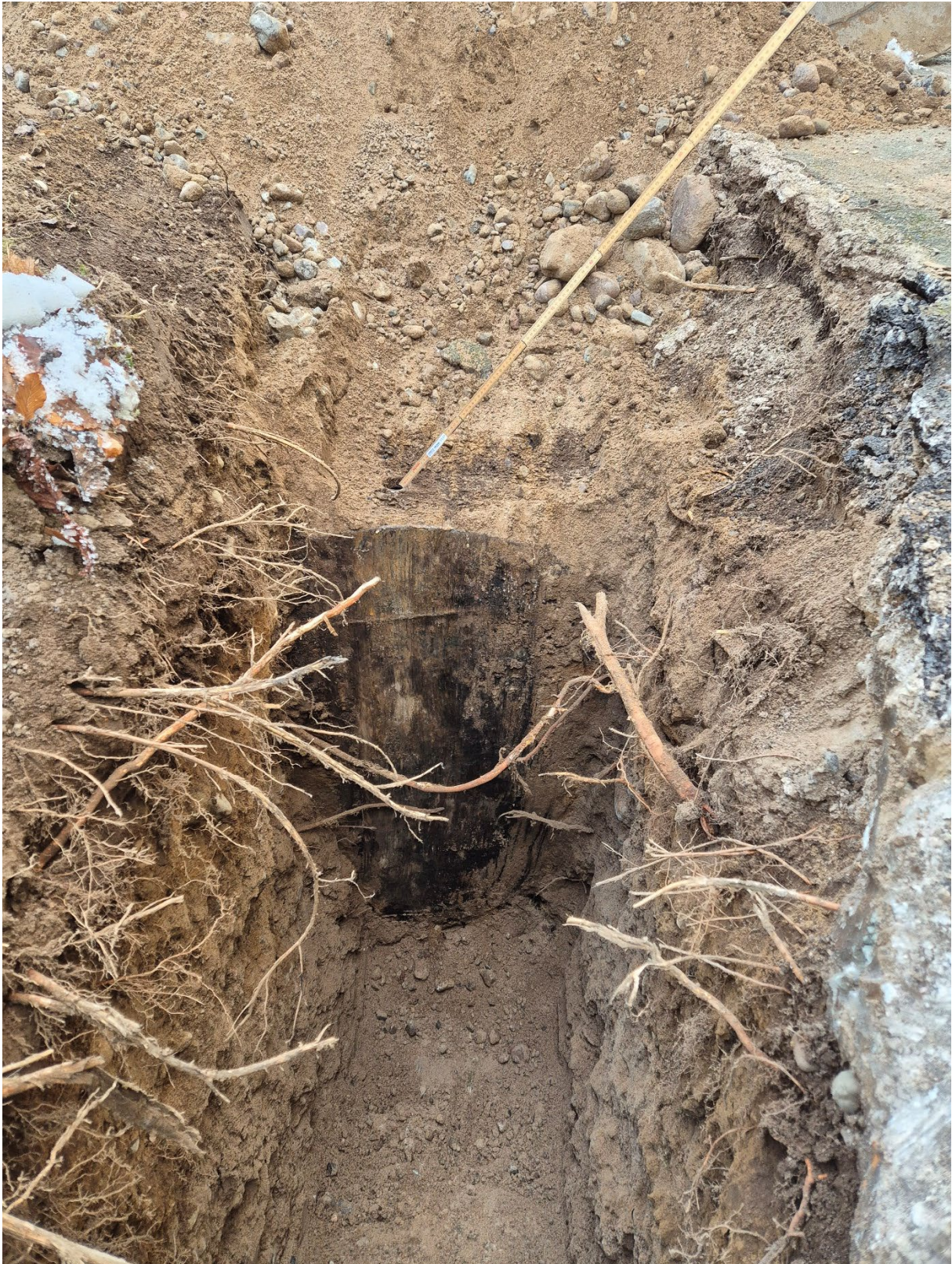
Figur 8: Provtagningspunkt D26. Oljecisternens nordvästliga gavel visas. Påfyllningshålet utpekas med hjälp av tumstock i bild.
