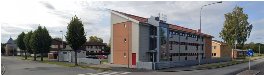
Figur 6: Bilden visar byggnaden inom fastigheten Falken 10 sett från korsningen Norra Bollgatan/Nygatan
