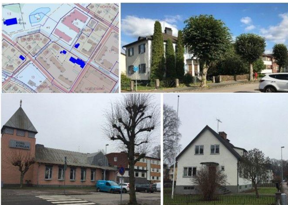
Figur 19: Utdrag ur CSM karta som visar värdefulla byggnader inom och i anslutning till kvarteret Falken. Bilderna visar (uppifrån ner) funktisstil villan inom fastigheten Falken 11, 40-tals villan inom fastigheten Örnen 15 samt Korskyrkan
