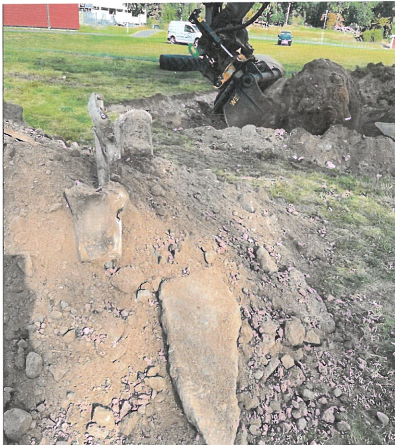
PG5, påträffad betong och asfaltssjök
