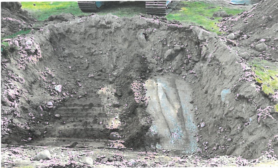
PG5 högra schaktbotten en asfalterad GC väg påträffas 1 meter under markytan, mull till vänster
